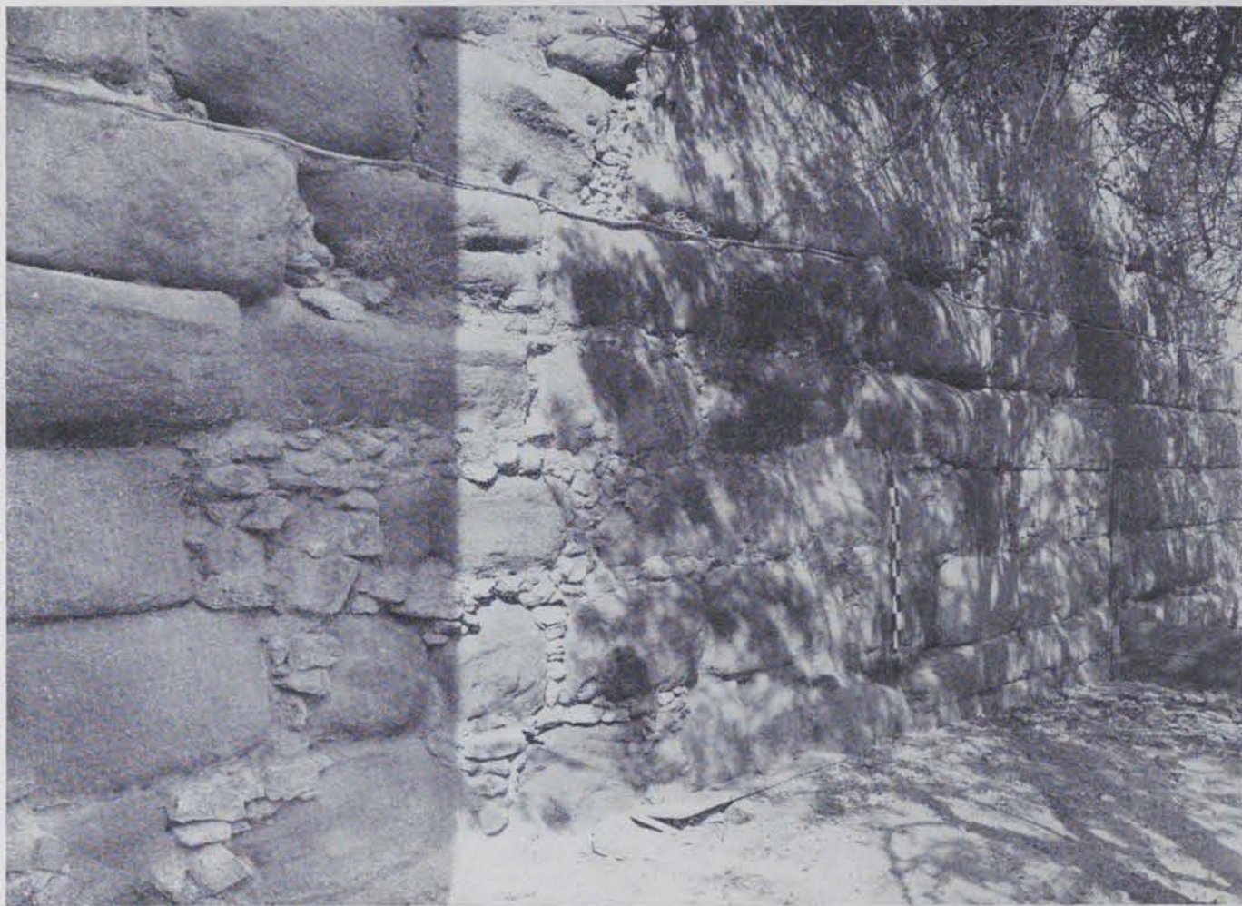
Fig. 119. — Mur romà en el pati del Col·legi de la Sagrada Família en el tros proper a la torre defensiva de la Porta Rufina. Apareixen sols a l'exterior els carreus ben uniformes de pedra sorrenca. Els de l'esquerra del gravat estan fortament degradats per l'humitat produïda per un jardí al qual serveixen de mur de contenció, mentre que els més llunyans de la dreta estan millor conservats per no estar sotmesos a aquella acció
