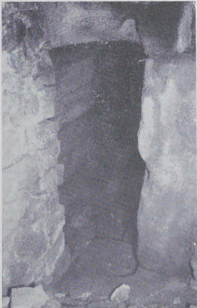
Fig. 110. — Girona : Poterna en el mur romà de la torre de la casa Bosmonart del carrer de les Ballesteries. El mur medieval perpendicular al romà, visible a l'esquerra del gravat, tapa en part l'entrada de la poterna; els dos brancals i el dintell d'aquesta estan fets d'una sola pedra
