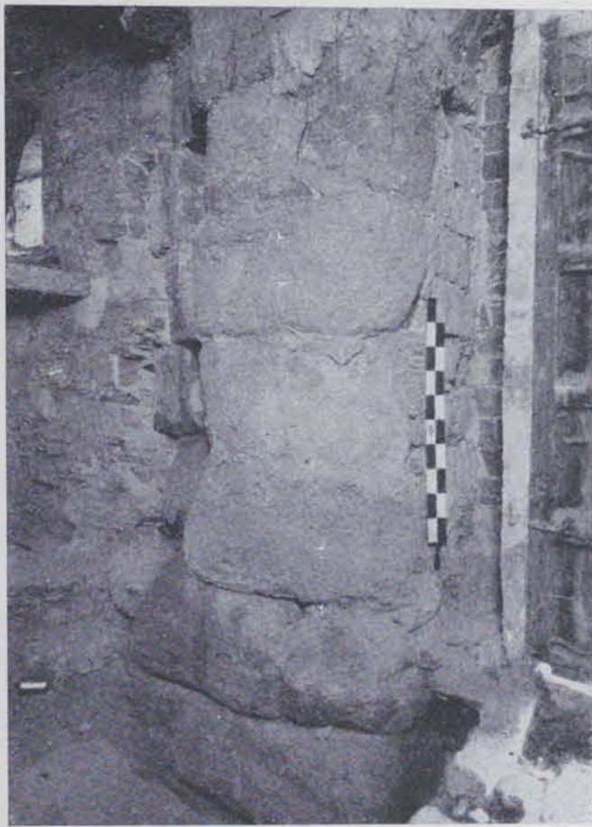
Fig. 118. - Porta Rufina : Pilar que serveix de brancal a les dues portalades de la Porta Rufina. En el tercer carreu començant per baix és ben visible el desgast produït pel fregadís dels botons de les rodes dels carros que giraven en l'estret passadís en angle del portal. Com que dit passadís era en pendent el senyal del fregadís està inclinat
