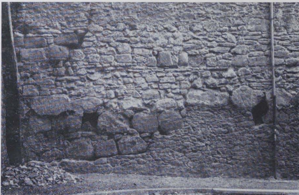
Fig. 124. — Part de llevant del mur de Casa Pastors a la placeta superior de St. Feliu tocant a la torre de Sobreportes. Blocs calissos de tècnica ciclopia, aparell petit amb morter, filades sorrenques a la part superior esquerra
