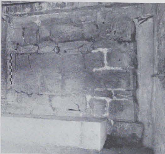
Fig. 121. - Angle de la dent de serra del segment de mur del Col·legi de la Sagrada Família, format tot ell de carreus calissos encoixinats, la qual cosa demostra que foren tallats per a formar parament exterior i no fonamentació
