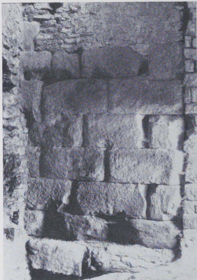
Fig. 111. - Torre Gironella : Mur de la torre romana. Segment situat en la part més exterior del soterrani medieval. La filada inferior és la fonamentació de pedra calissa. A la dreta del gravat es veu l'angle N. W. de la torre amagat pel mur medieval de petits carreus que continua en la mateixa direcció
