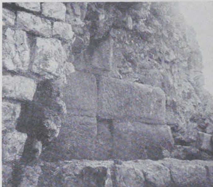
Fig. 113.—Torre Gironella : Mur W. de la torre romana descobert en les excavacions de l'Institut. Els grans carreus d'arenisca, defensats durant segles de l'acció del temps pel revestiment medieval, han conservat perfectament el seu encoixinat
