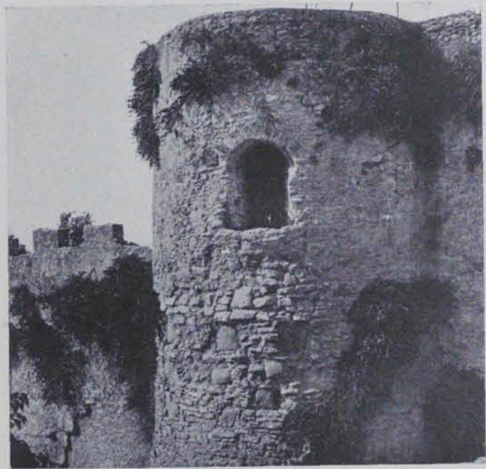
Fig. 122. - Torre cilíndrica de Casa Agullana: En la finestra, descoberta en els treballs de l'Institut, són visibles els dos murs concèntrics que formen la part superior de la torre
