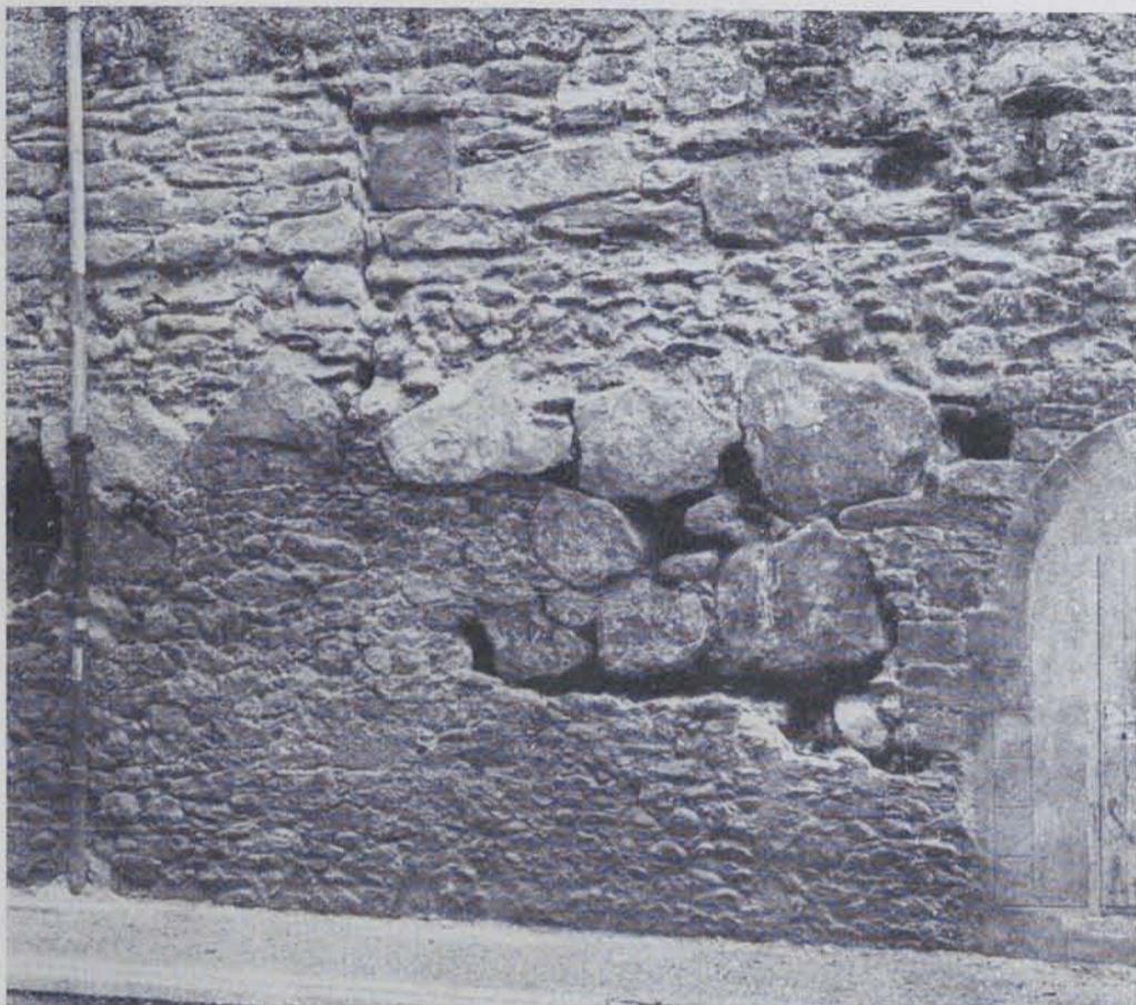
Fig. 125.—Part central del mur de Casa Pastors a la placeta superior de St. Feliu. Filades de blocs calissos irregulars. A sota un dels murs moderns de sosteniment. Vers la part central superior un dels reclaus
