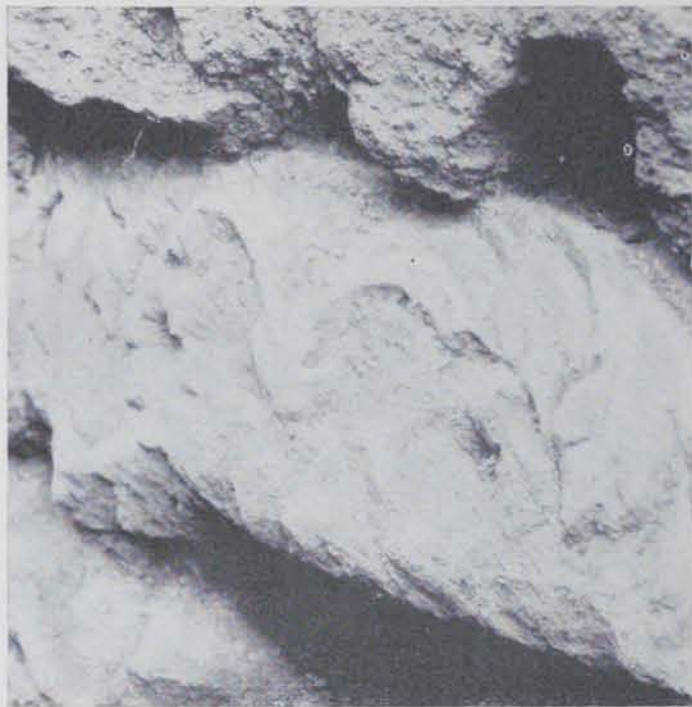
Fig. 115. — Pedra del fonament de la torre del telègraf, en la qual hi ha esculpida una garlanda
